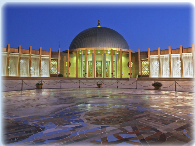
FIBES Sevilla Intercambiadores de placas T20
